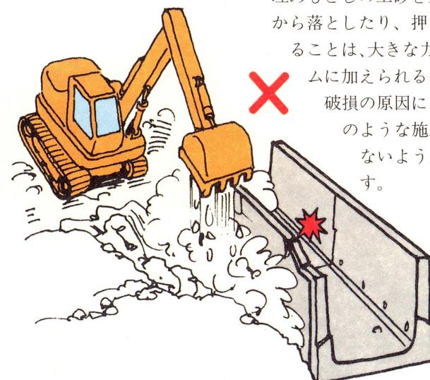
埋めもどしの土砂を重機で高い所から落としたり、押しつけたりすることは、大きな力が、フリュームに加えられることになり、破損の原因になります。このような施工方法は行わないようお願いします。
