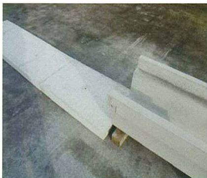
①敷板のセット
