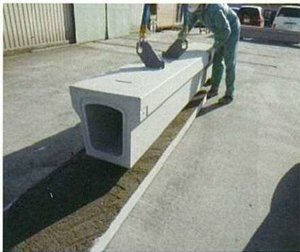
⑥製品吊り上げ・布設
