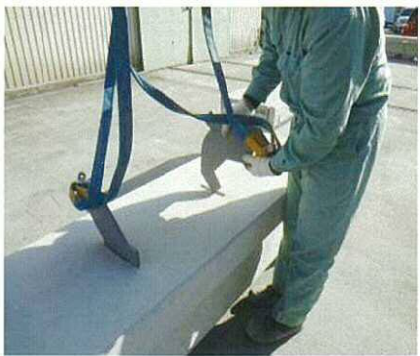
⑤専用吊り具のセット
