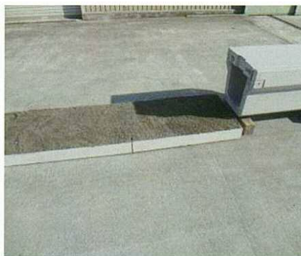
②敷モルタルの施工
